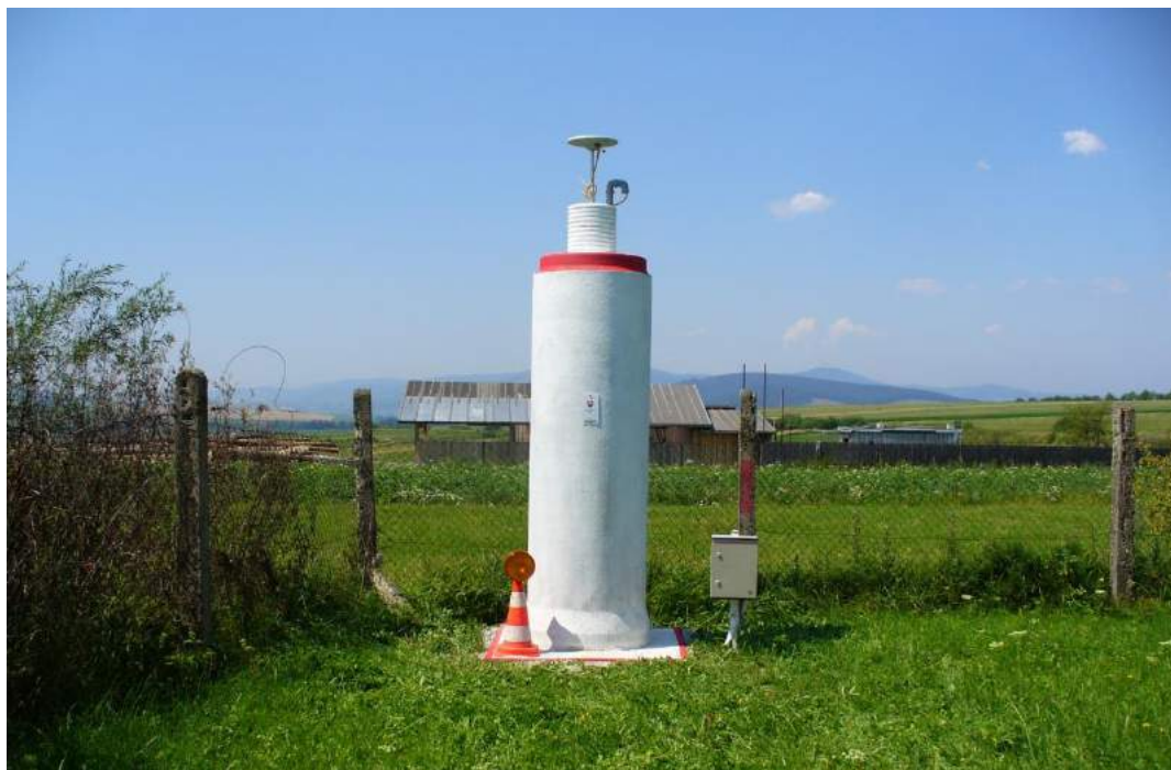
Obr.28 Ukážka stabilizácie referenčnej stanice LIE1 formou železobetónového piliera.
